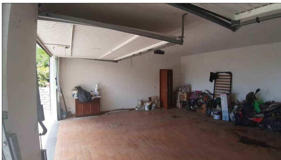
foto 14 - vista del seminterrato della stessa costruzione.
