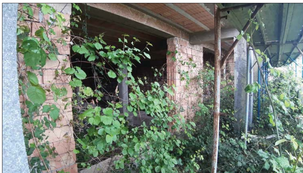
foto 19 - vista dell'ingresso al piano seminterrato sub 2.
