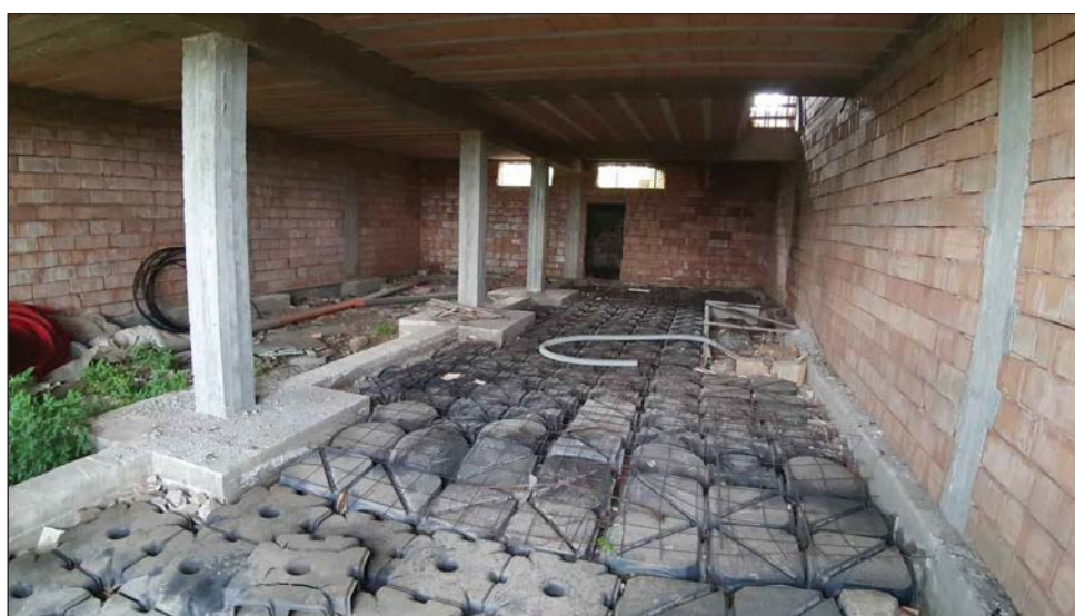
foto 20 - vista del piano seminterrato sub 2.
