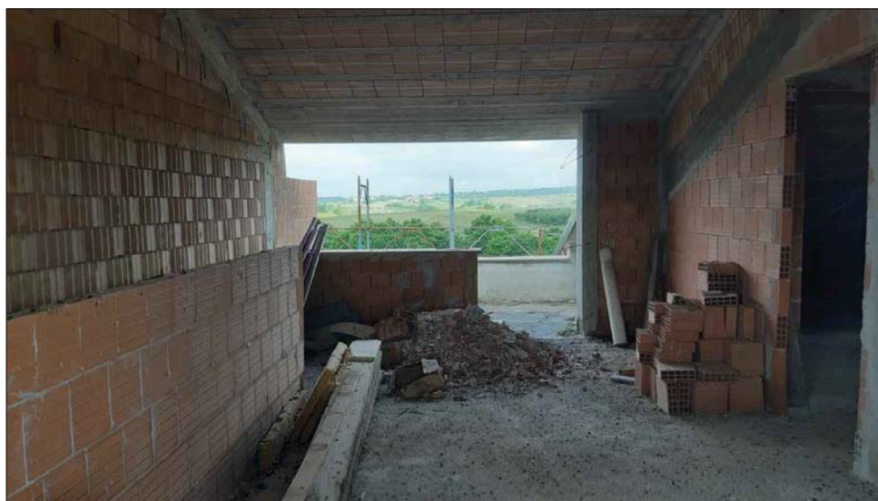
foto 23 - vista del piano 1° del sub 2.
