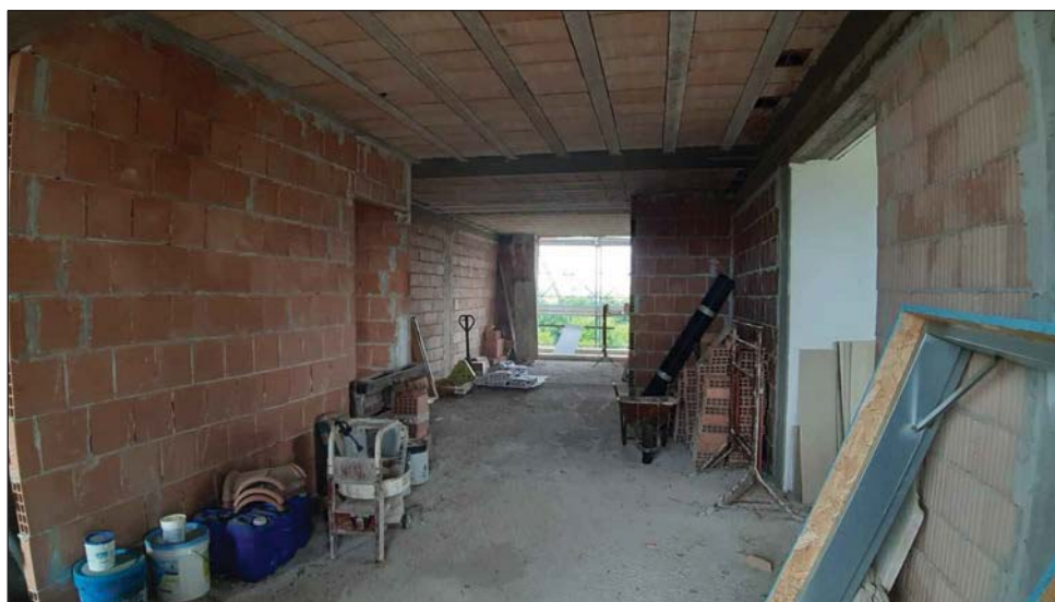
foto 21 - vista del piano terra del sub 2.
