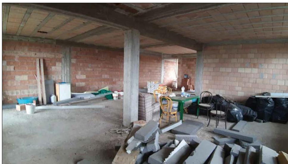
foto 25 - vista del piano terra del sub I.
